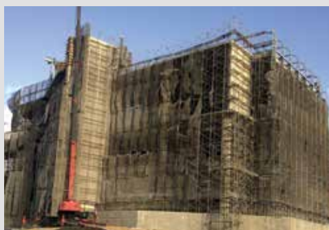
Tung Ho Staal Fabriek, Taiwan
