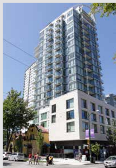
Ondergrondse parkeergarage, High Rise
